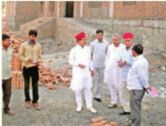
सुमेरपुर में निर्माणाधीन टाउन हॉल का निरीक्षण करते उपमुख्य सचेतक।
